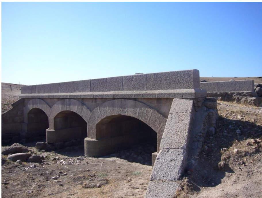
Puente restaurado donde se aprecia el excesivo estiaje que soporta los arroyos que vierten el Tajo a su paso por el término de Valdehúncar.
